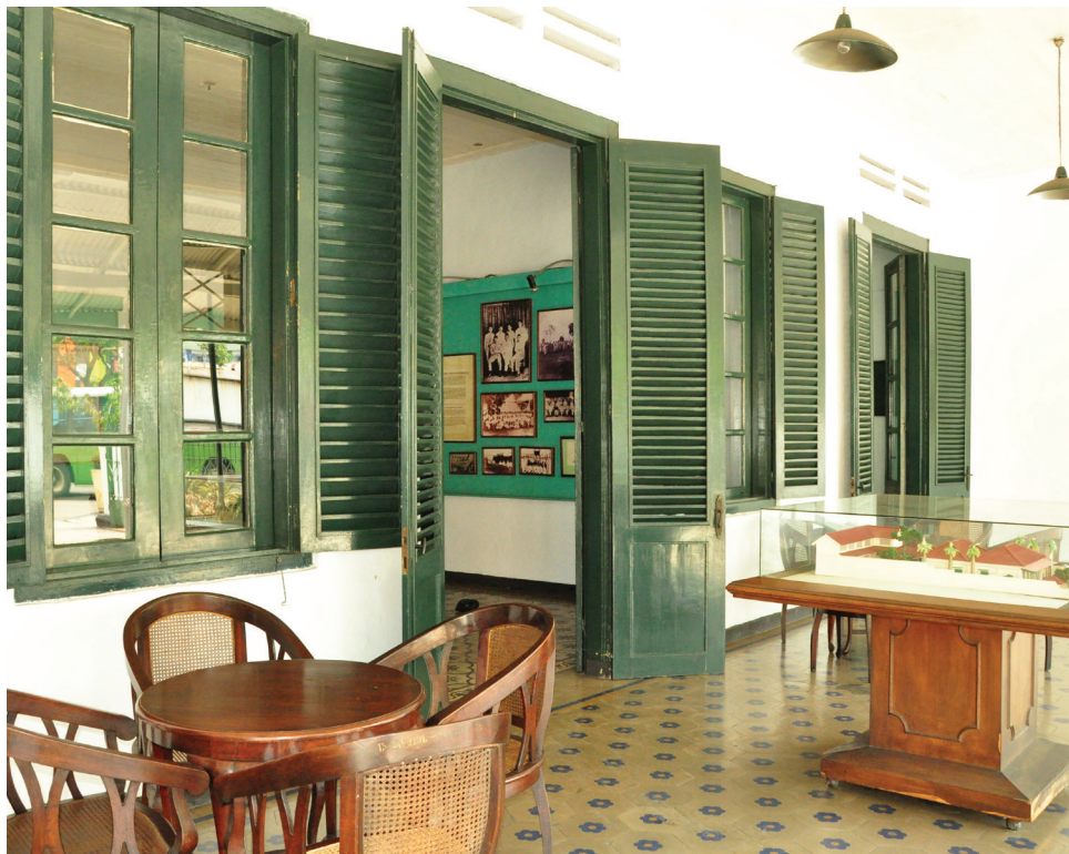
Kondisi Gedung Sumpah Pemuda yang berlokasi di Jl. Kramat Raya 106, Jakarta Pusat.
