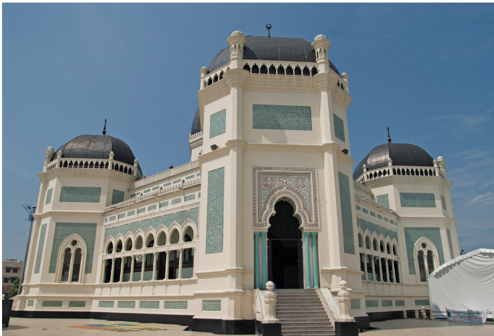
Masjid Raya al-Mashun atau Masjid Raya Medan menjadi bukti akulturasi budaya di tanah Sumatra Utara. Pembangunan masjid diprakarsai oleh Sultan Maimum Al Rasyid Perkasa Alamsyah pada 1906 (selesai pada 1909). Masjid ini bergaya Moorish dengan perpaduan arsitektur Eropa, India, dan Timur Tengah.
